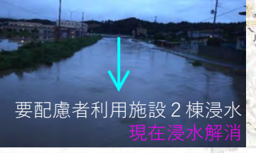
尾別川溢水状況
