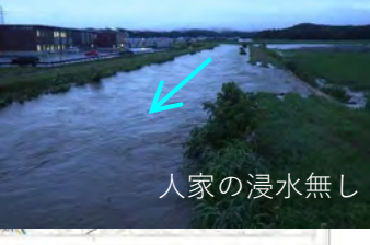
宮野沢川越水状況
