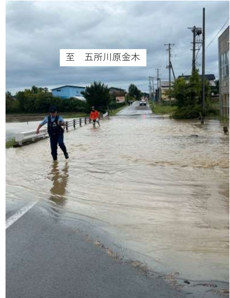
②国道339号（五所川原市長富地内） 路面冠水状況
