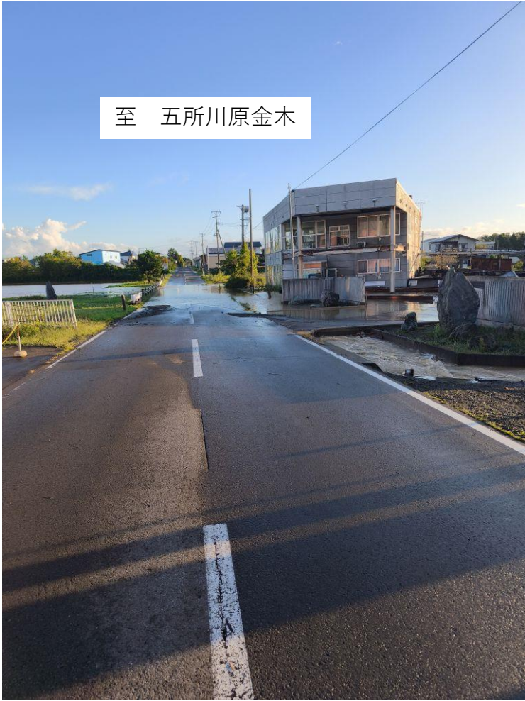
②国道339号（五所川原市長富地内） 路面冠水状況
