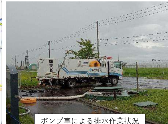
ポンプ車による排水作業状況
