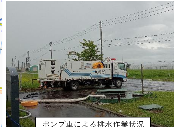
ポンプ車による排水作業状況
