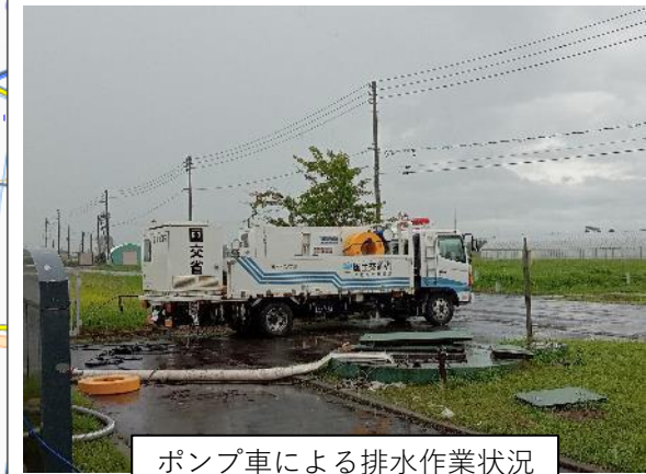
ポンプ車による排水作業状況
